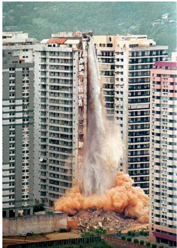
Erros de cálculo e materiais de baixa qualidade levaram ao desabamento e à implosão do edifício Palace 2, no Rio de Janeiro, em fevereiro de 1998 Foto: Patrícia Santos/Folha Imagem
